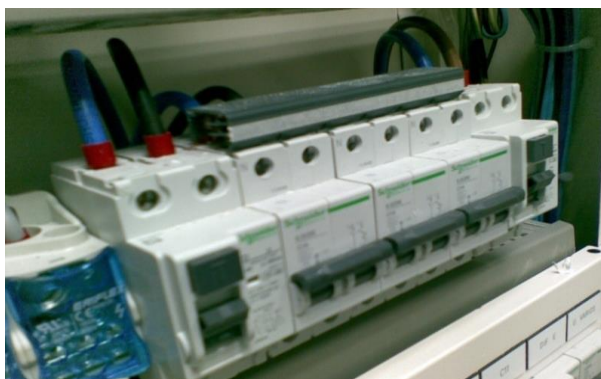
Figura 11 – Conexión de aparamenta mediante peine de distribución
